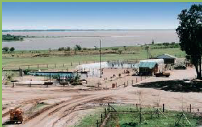
Primera Perforación en ARGENTINA: Pozo Federación -1994-
